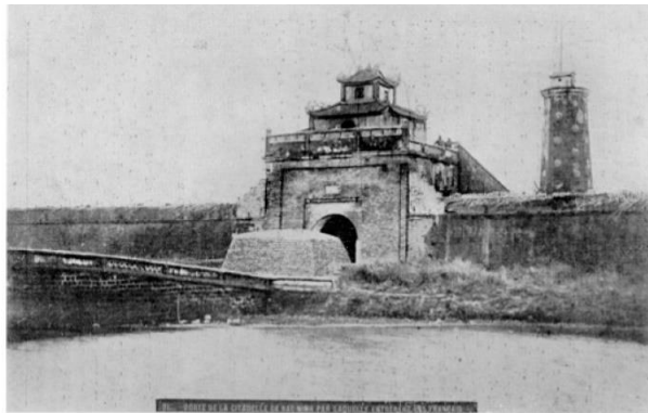
Planche LXXVI | Photo XV J. — La porte principale de la citadelle de Bắc-Ninh, en mars 1884.
