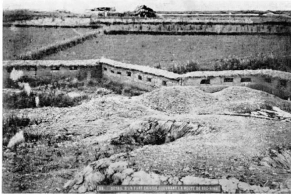
Planche LXXIV | Photo XIII J. — Un ouvrage d'arrêt sur la route de Hanoi à Bắc-Ninh, en 1884.
